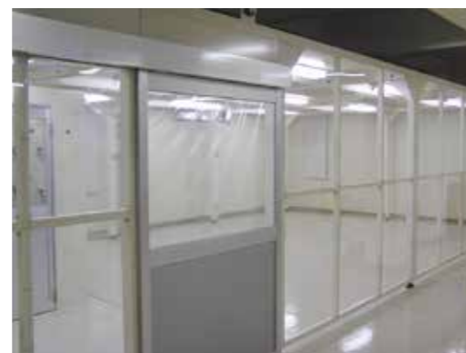
施工例:全面帯電防止アクリル貼りクリーンブース
